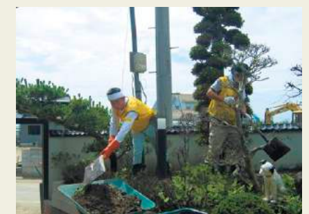
▲津波被害にあわれた家屋での泥出し作業
